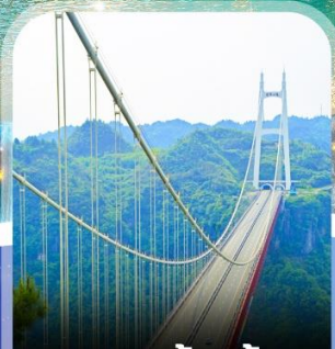
สะพานอ้ายจ้าย
